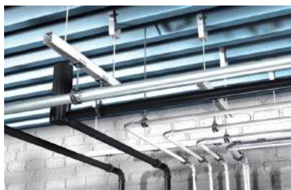
Крепление подвесного трубопровода к профнастилу
