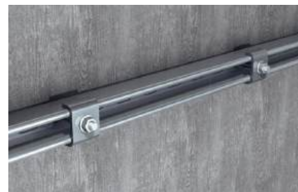
Монтаж шин к стене
