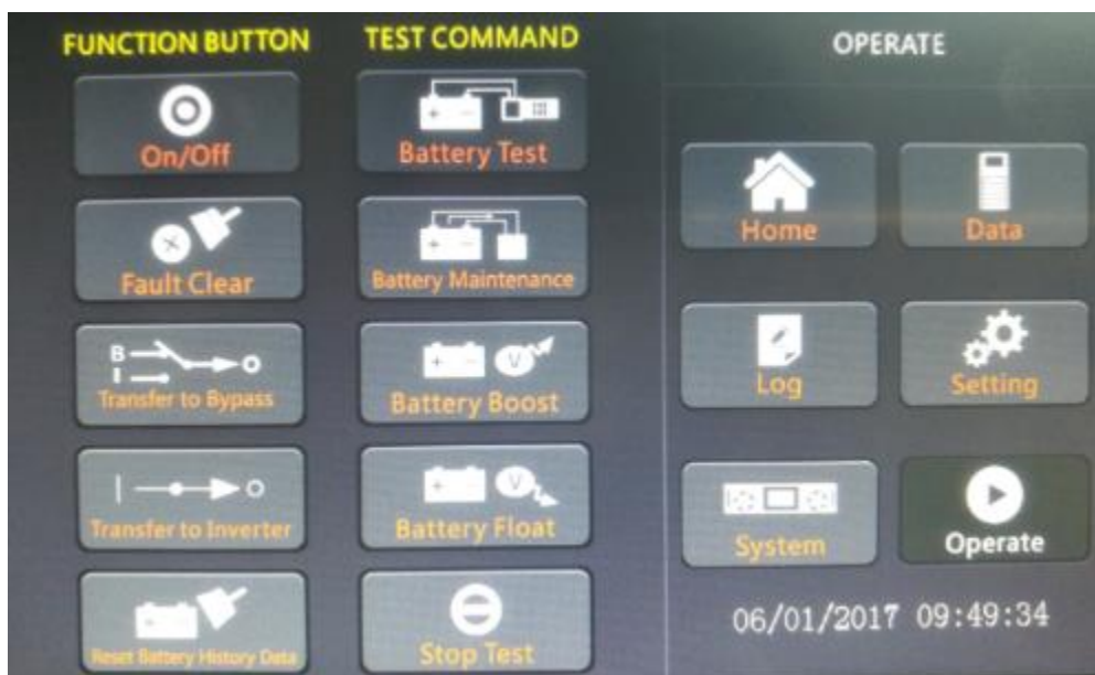
Рисунок 5.3 Тестирование батарейного массива Battery maintenance
