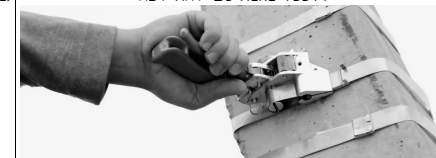
Рис. 7. Установить оборудование на опору, затянув ленту с помощью бугеля, используя предназначенный для этого инструмент.
