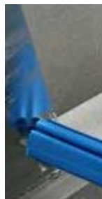
Стыковка нижнего профиля у стальных стоек
