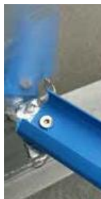
Монтаж нижнего профиля, стык
