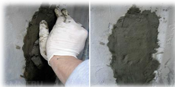
Рисунок 5 - Пример ремонта материалом «АКВАТРОН-8П»
