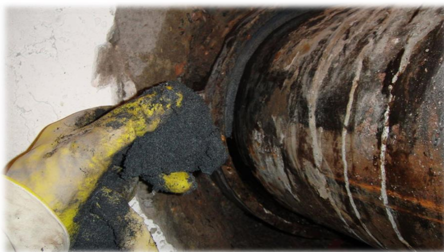
Рисунок 9 - Герметизация вводов коммуникаций материалом «АКВАТРОН-6Ш» шовный
