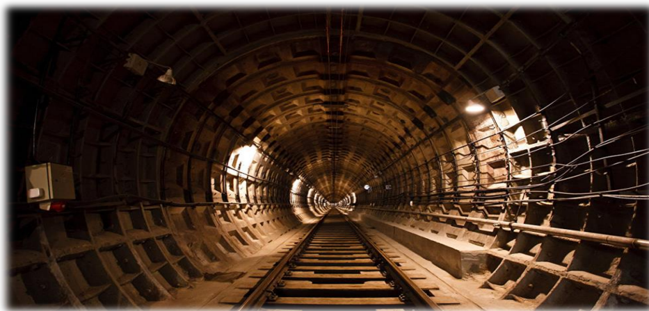
Рисунок 4 - Ремонт тоннеля Бакинского метрополитена
