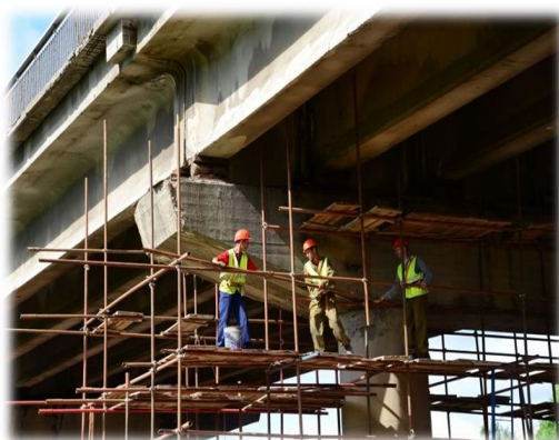
Рисунок 7 - Ремонт мостовых опор материалами «АКВАТРОН»
