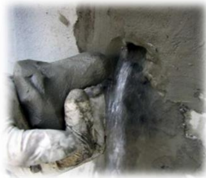
Рисунок 3 - Заделка напорной (активной) течи материалом «АКВАТРОН-8Б»
