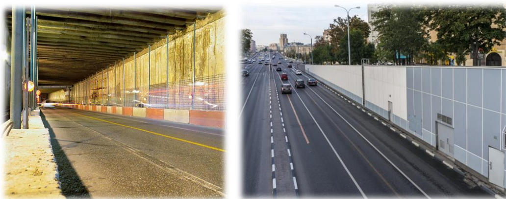
Рисунок 5 - Ремонт Таганского транспортного тоннеля в г. Москве
