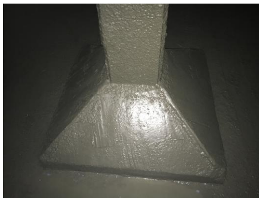
Рисунок 13 - Нанесение материала «АКВАТРОН-6» торкрет-способом на стены и потолок резервуара хранения воды
