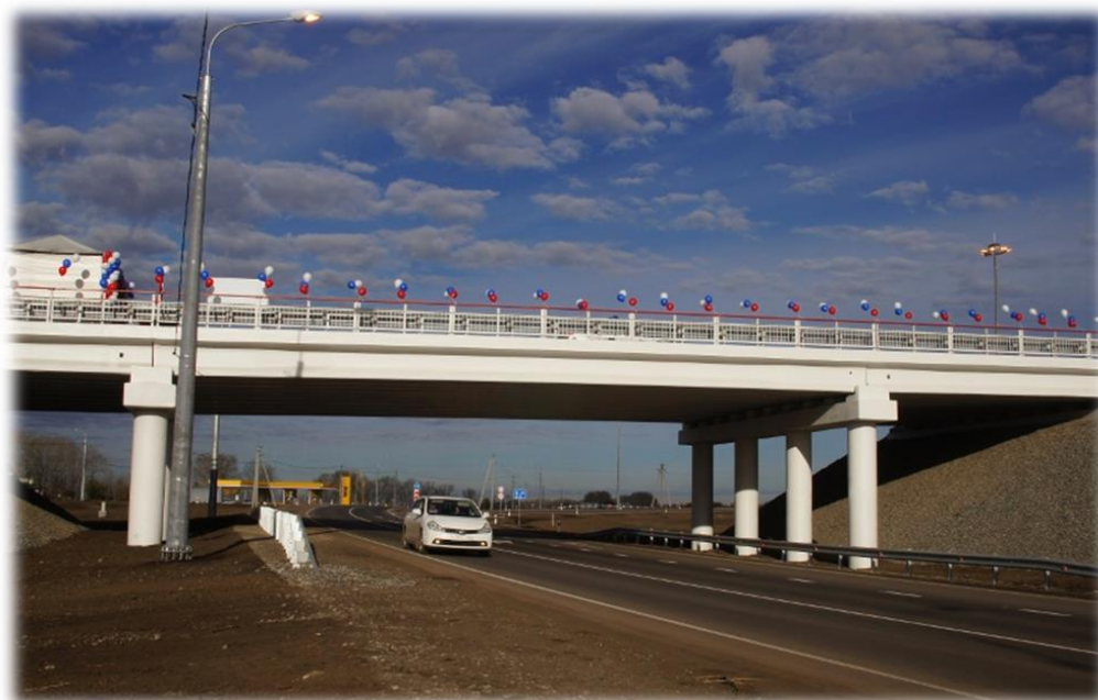
Рисунок 2 - Ремонт объездного моста г. Бийска (бетон + 0,5 % «АКВАТРОН-12»)
