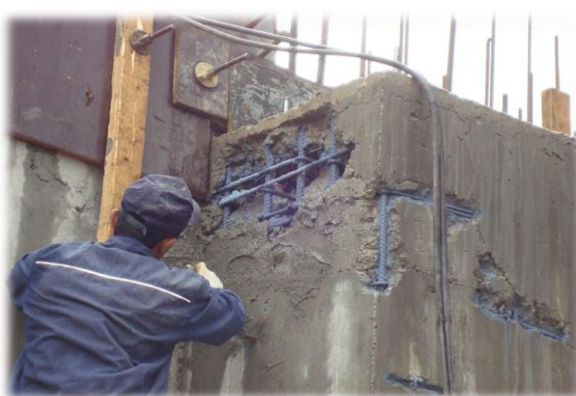
Рисунок 7 - Ремонт мостовых опор материалами «АКВАТРОН»
