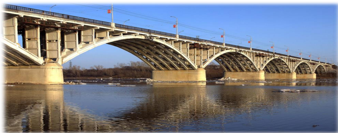
Рисунок 1 - Ремонт коммунального моста г. Бийска (бетон + 0,5 % «АКВАТРОН-12»)
