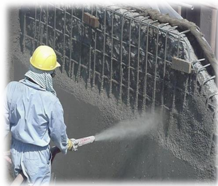
Рисунок 11 – Торкрет-способ
