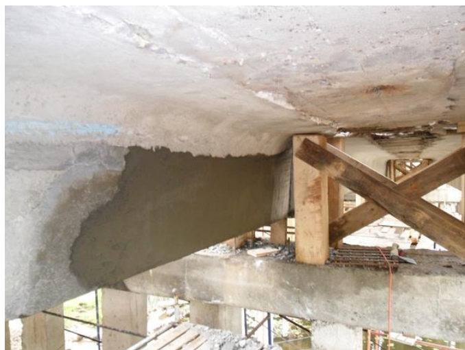
Рисунок 8 - Ремонт мостового перехода материалами «АКВАТРОН»
