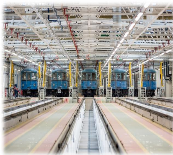
Рисунок 6 - Ремонт электродепо «Митино» Московского метрополитена
