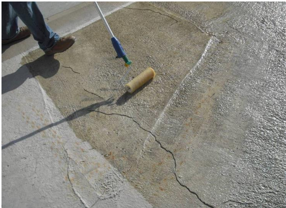
Однокомпонентный полиуретановый праймер для впитывающих оснований, входящий в систему покрытий с мембраной
