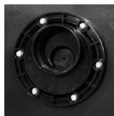
Рис. 5 Поворотный диск в сборе с неподвижным диском и саморезами
