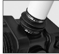
Рис. 10 Монтаж вентиляционного трубопровода
