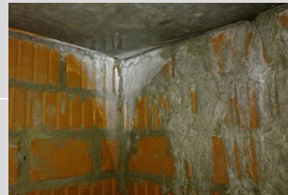
Теплопотери из-за образования Мостика холода,
