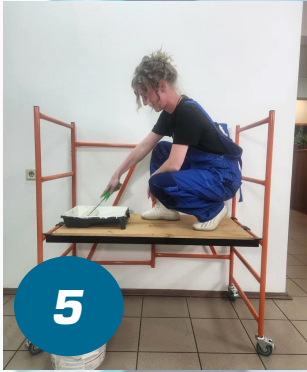
Следует работать на двух настилах расположенных на одном уровне.
