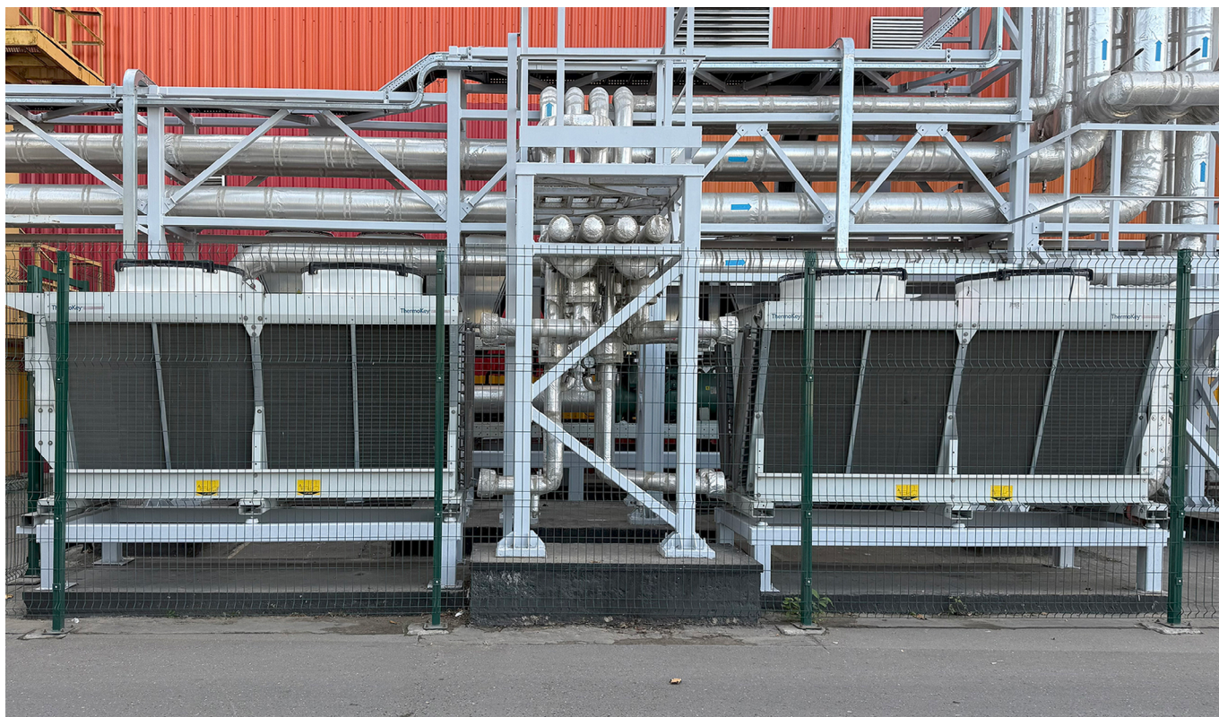
Рис. 3 Пример горизонтальных воздушных конденсаторов
