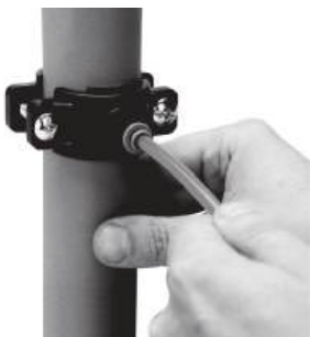
Рис.4. Вывод воздуха в дренаж.
