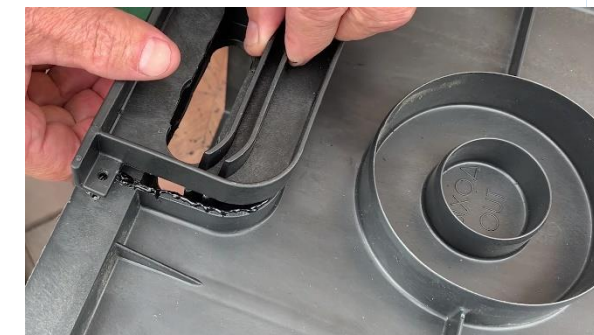
6. Стыкуем на герметик переходник
