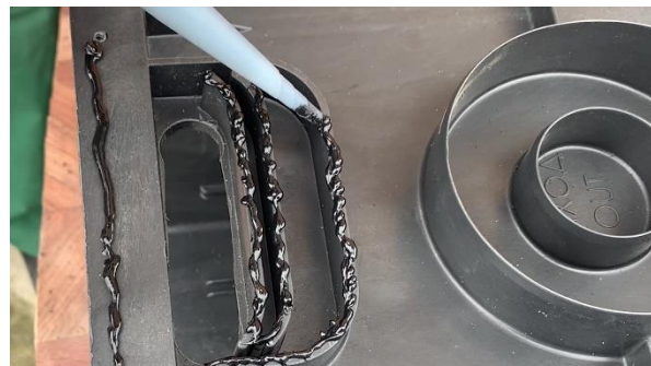
5. Герметизируем место соединения переходника и дождеприемника
