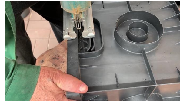
3. Такое же отверстие вырезаем и в дождеприемнике
