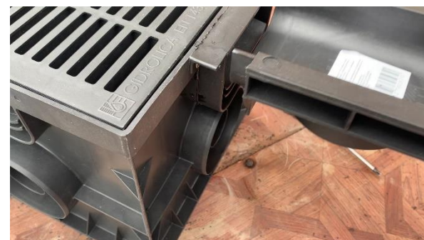
8. Заводим торец лотка в переходник и место стыка также герметизируем
