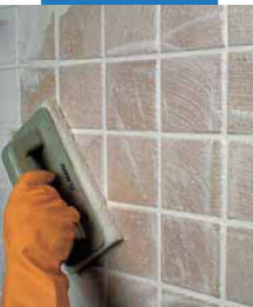
Очистка плитки одинарного обжига абразивным падом
