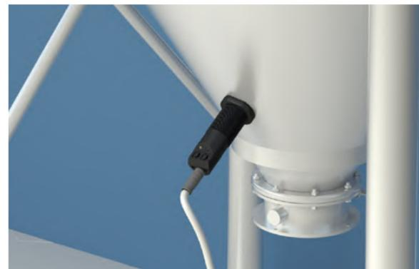
Сигнализация предельных уровней заполнения бункера кормом
