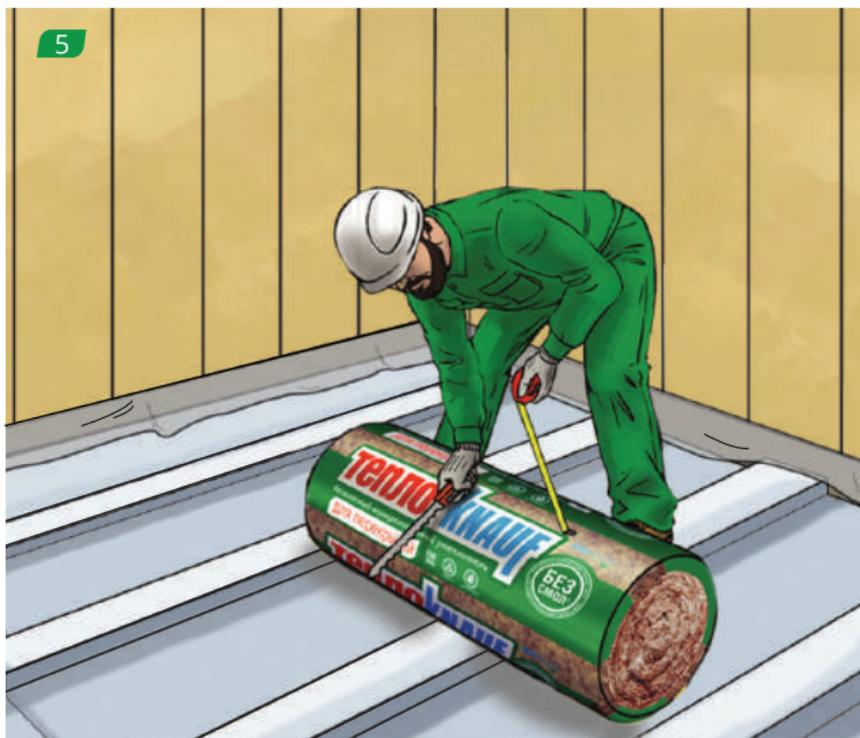
Нарезаем теплоизоляцию по ширине из расчета «расстояние между балками + 10 мм».
