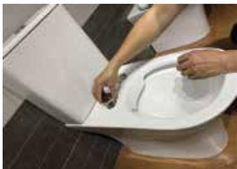
4. Установите сидение и при необходимости отрегулируйте с помощью болтов.
