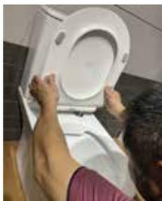
Для зажима фиксирующих элементов требуется приложить определенные физические усилия. Однако чрезмерное физическое усилие может повредить сиденье с крышкой или сам унитаз. Будьте предельно аккуратны и внимательны!
