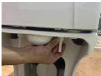
7. Соедините впускную арматуру с системой холодного водоснабжения, используя гибкую подводку необходимой длины (в комплект не входит; при затяжке накидных гаек необходимо придерживать рукой шланг гибкой подводки).
