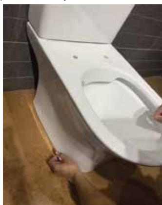
3. Просверлите отверстие для крепления унитаза.
