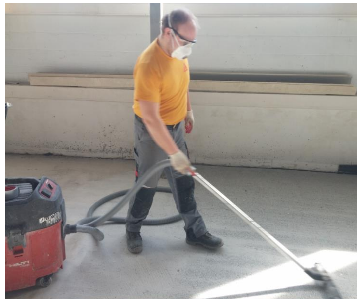
Обеспыливание поверхности бетонного основания промышленным пылесосом
