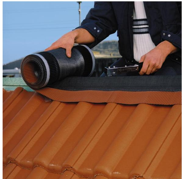
**Важно!** Кровельный материал перед проклейкой рулона должен быть чистым и сухим. Предпочтительно работать при температуре воздуха выше **+5° С**. Не рекомендуется применять DELTA®-ECO ROLL во время дождя и снега.
