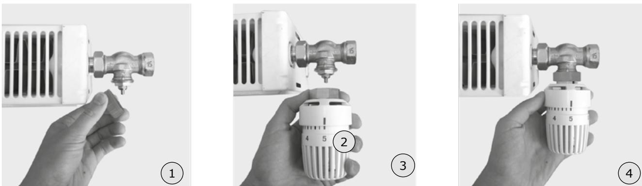
1. Снимите защитный колпачок с термостатического клапана.
