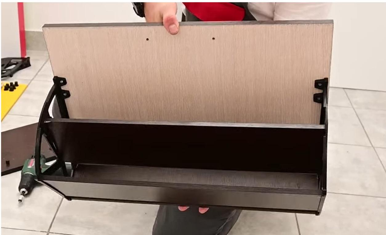
3. В боковых стенках обувницы просверлить отверстия под втулку и упор в соответствии с чертежом механизма. Вставить втулку вращения фасада в отверстие боковой стенки обувницы. Вставить упор для штифта в отверстие боковой стенки обувницы. Вставить втулку оси вращения механизма обувницы.
