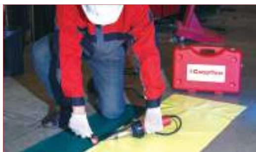
Сварка полимерных материалов на производствах и строительных объектах
