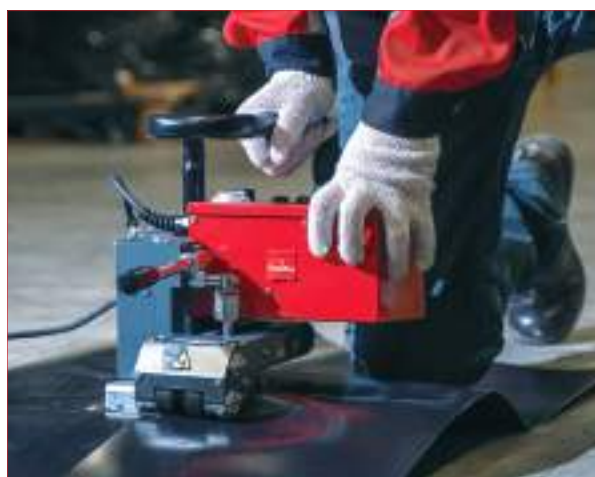
Сварка геомембраны
