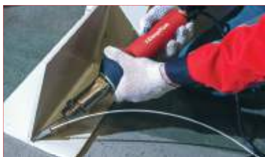
Сварка прутком
