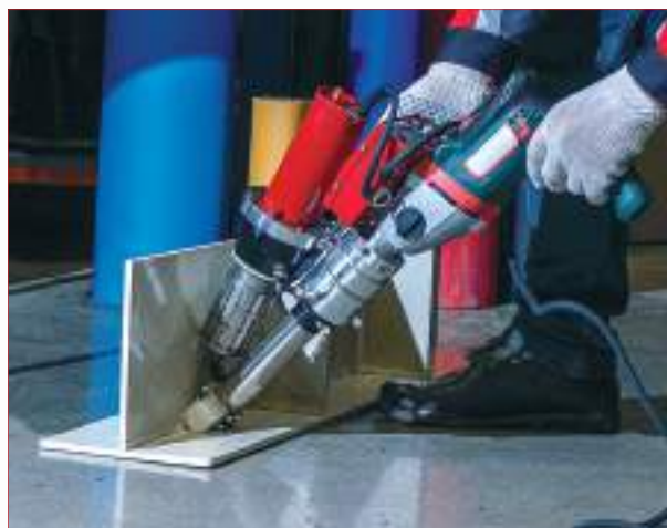
Сварка углов, стыков
