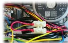
муфту в корпусе и подключите его к клеммам колодки.
