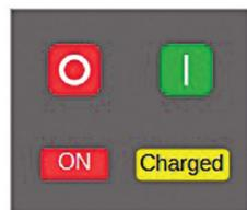
выключатель включен и включающие пружины взведены
