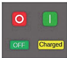
выключатель отключен и включающие пружины взведены
