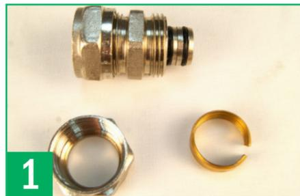
1 Удостоверьтесь в отсутствии внешних повреждений у обжимных фитингов перед монтажом. «Сухарь» по линии разреза не должен иметь заусенцев.
