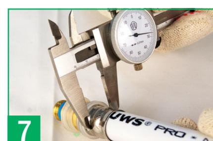
7 Качество выполненного пресс-соединения проверяется замером штангенциркулем максимального диаметра зоны обжатия. Он должен быть не более значений указанных в таблице.
