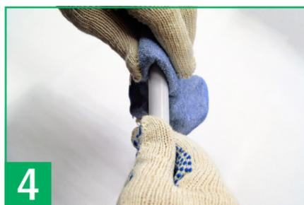
**4** Обезжириваем и очищаем от возможных загрязнений свариваемые поверхности. Для этого удобно использовать спиртовые одноразовые салфетки.
