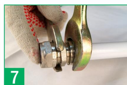
7 Рожковым ключом нужного номера накидная гайка закручивается на необходимое кол-во оборотов.
