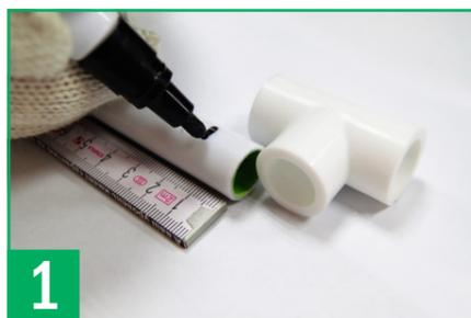
**1** На подготовленном к сварке торце трубы отмечаем на расстоянии равном глубине посадочного гнезда фитинга плюс 2 мм.
