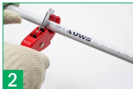
**2** Отрезаем кусок трубы при помощи специальных ножниц строго перпендикулярно оси трубы.
