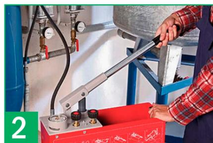
**2** При опрессовке давление поднимается в 1,5 раз относительно расчётного давления в системе, но не менее 6 бар. Система считается выдержавшей испытание, если в течении 10 минут падение давления не привисило 0,5 бар.
