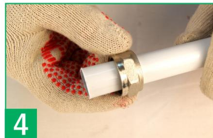
4 Далее на трубу надевается накидная гайка.
