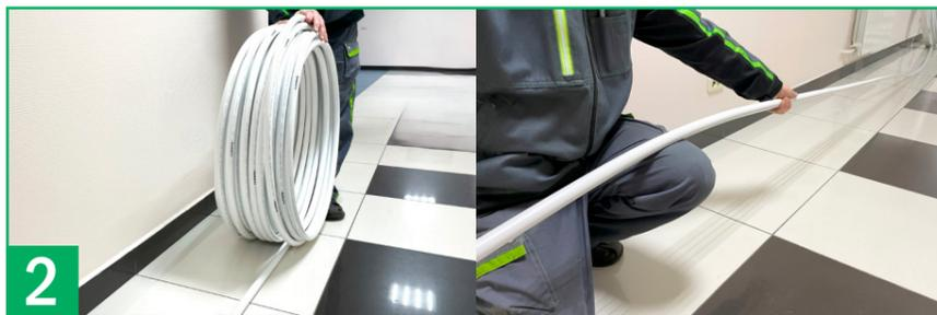
2 Труба PPR-AL-PPR имеет большую жёсткость, поэтому необходимо размотать длинный хлыст, выровнять, а затем отрезать необходимую длину.
