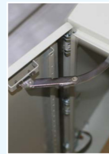
Ограничитель. Предотвращает случайное закрытие открытой дверцы; применимо для суровых условий эксплуатации, например, на открытом воздухе, на судах
