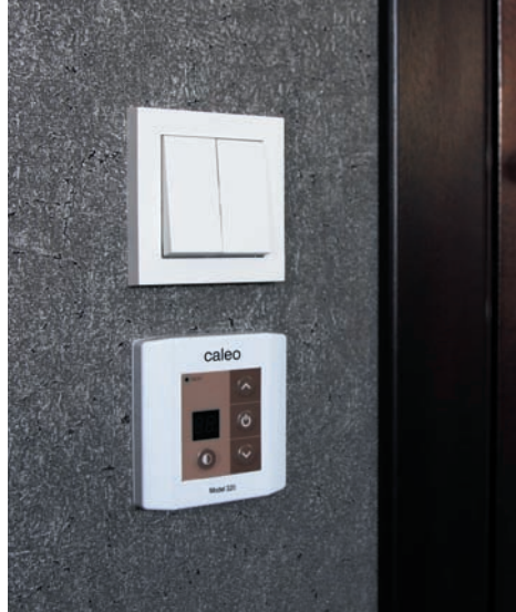
Рис. 28. Терморегулятор, подключенный к сети
