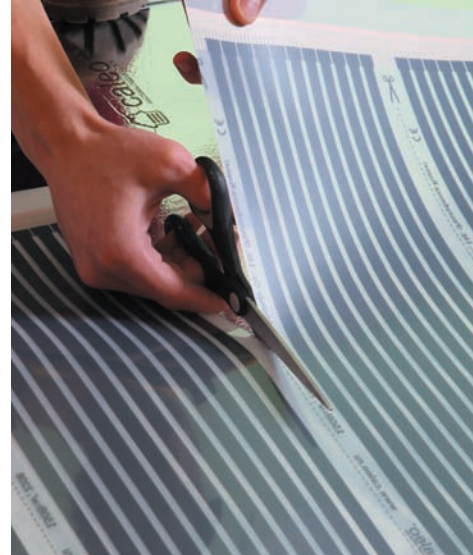
Рис. 8. Разрезание термопленки CALEO по линиям отреза
