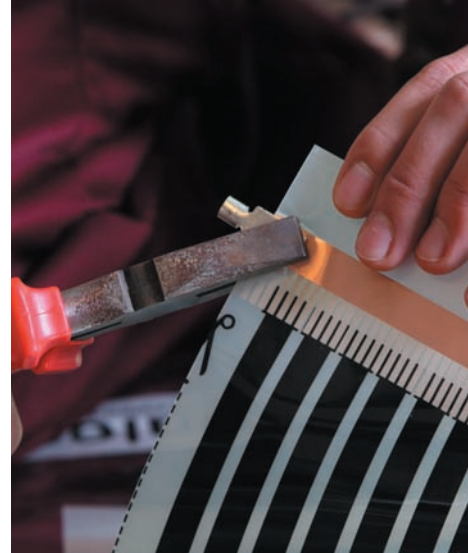
Рис. 11. Крепление контактного зажима к термопленке
