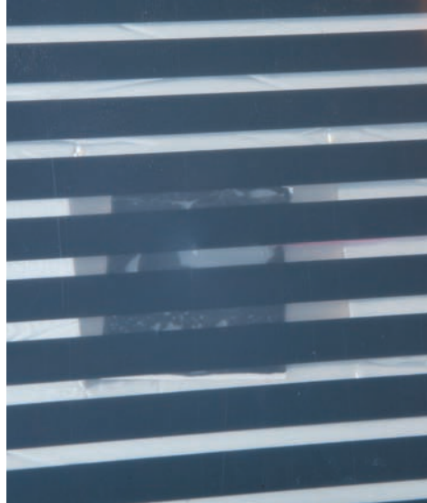
Рис. 27. Установленный и приклеенный датчик температуры пола. Вид сверху термоплёнки
