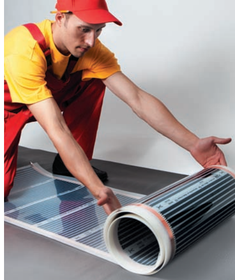
Рис. 7. Раскатывание рулона теплого пола на теплоотражающем материале
