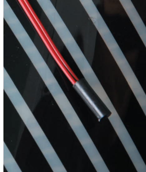
Рис. 23. Установка датчика температуры пола
