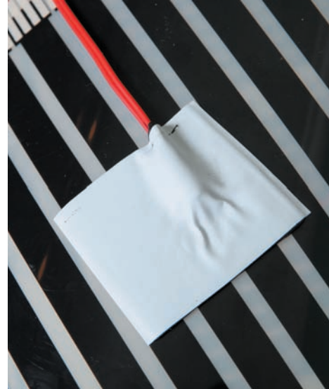
Рис. 26. Установленный и приклеенный датчик температуры пола. Вид снизу термолентки
