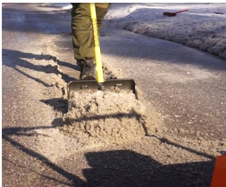
Рис.7. Очистка поверхности от ледяной крошки.
