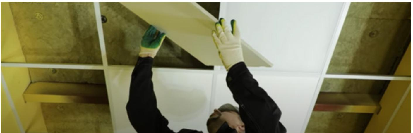
Плиты по периметру готовим под размер. Для этого замеряем расстояние до стены и переносим его на панель. Аккуратно режем панель по разметке с помощью канцелярского ножа.
