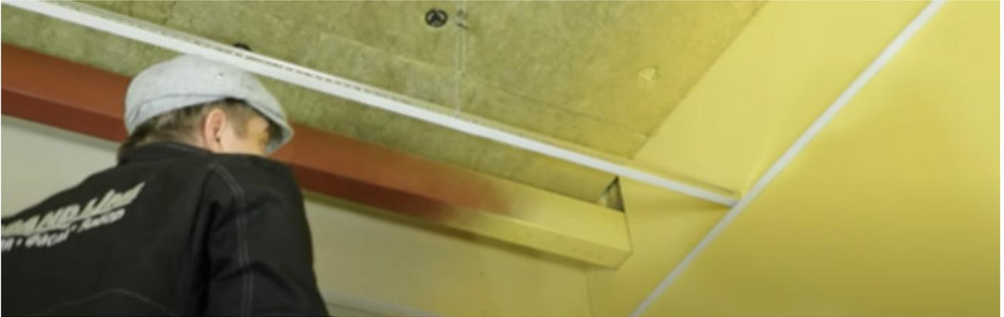
Будьте внимательны при резке профилей: несущие профили имеют пожарные компенсаторы только с одной стороны, поэтому, если нужно отрезать и использовать фрагмент, используйте ту часть профиля, где есть пожарные компенсаторы. Заводим несущий профиль за пристеночные уголки и цепляем его за европодвесы. (Схема 4)
