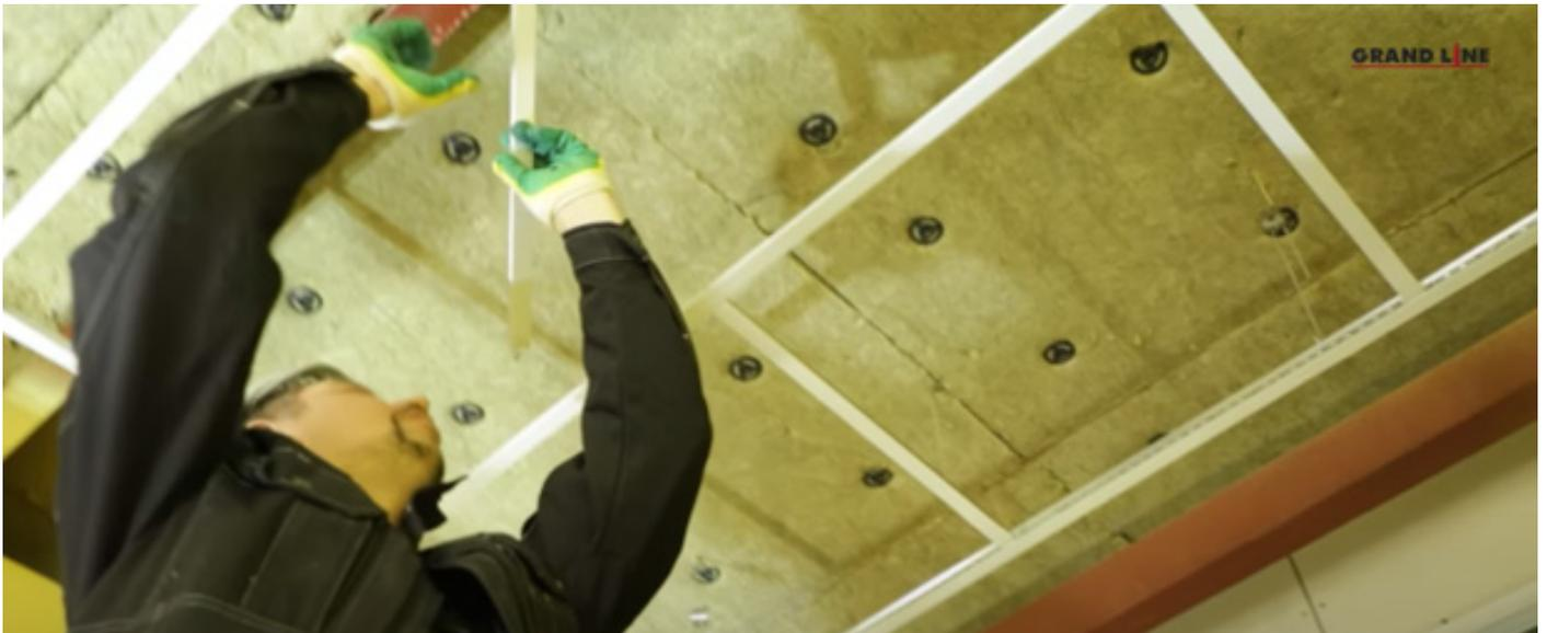
Для фрагментов по периметру потолка подгоняем планки до нужного размера, если этого требует ваша раскладка. Со стороны, прилегающей к пристеночному профилю, не забудьте срезать замок. По указанному принципу собираем весь основной каркас потолка. Профили L=600, которые располагаются по периметру комнаты, мы рекомендуем монтировать в последнюю очередь и размещать по противоположным сторонам, чтобы каркас стал враспор. (Этап 4)
