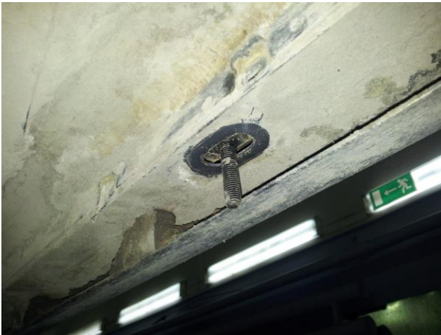
Рис.2 Установка шпильки закладной M10
