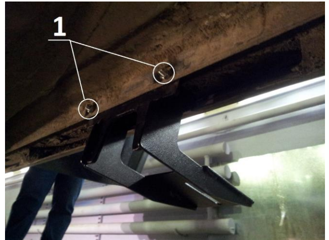
Рис.3 Установка кронштейна
