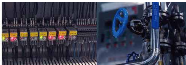
Полная переработка системы водоснабжения/энергоснабжения/отопления
