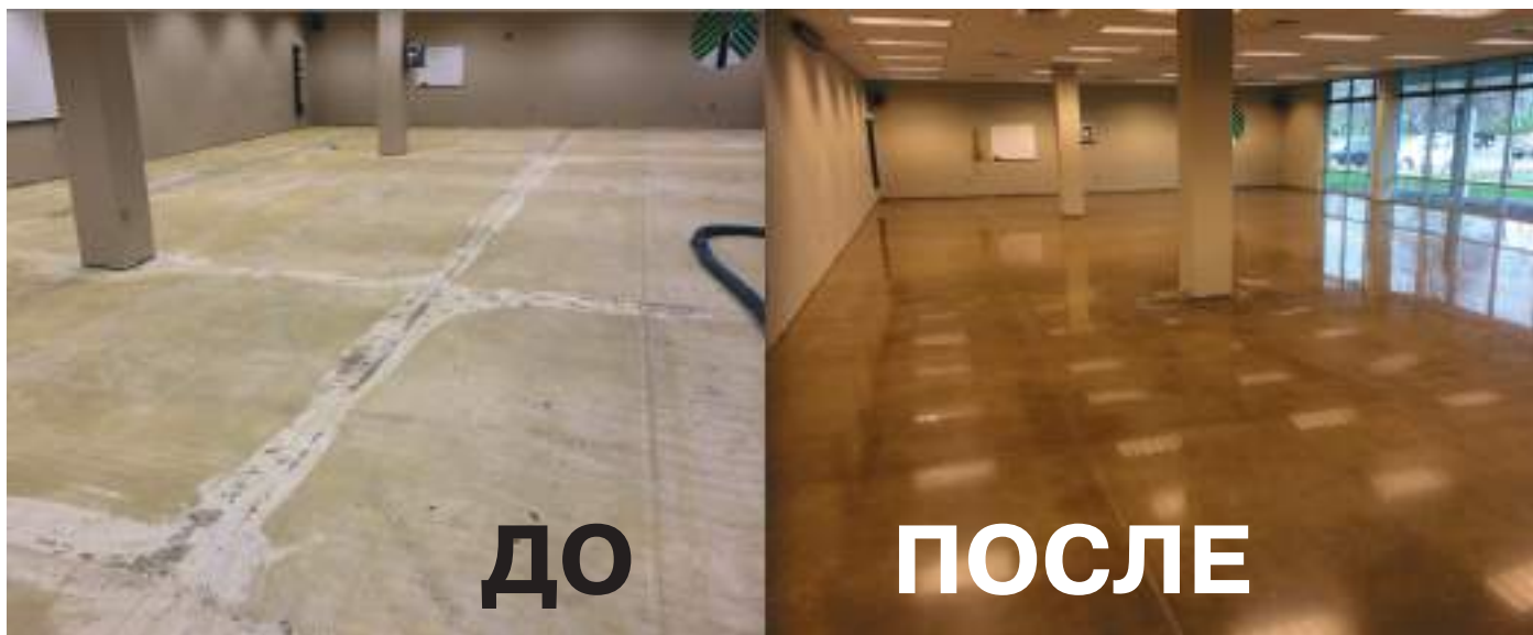
Полировка бетона
