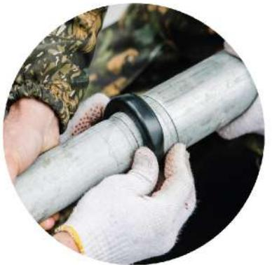
6. Соедините муфтой два конца трубы так, чтобы торец муфты попал в желоб.
