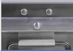
**Все клепочные соединения на стержневых заклепках** обеспечивают долговечность конструкции
