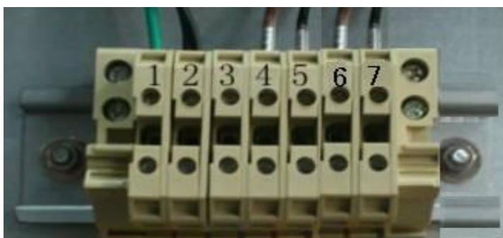
Рисунок 3-15: Сухие контакты ИБП мощностью 400 ~ 500 кВА
