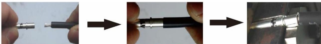
Вставьте собранный кабель в корпус гнездового разъема:
