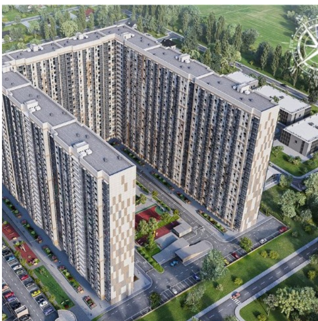
Город: Ростов-на-Дону Название объекта: ЖК West Side
