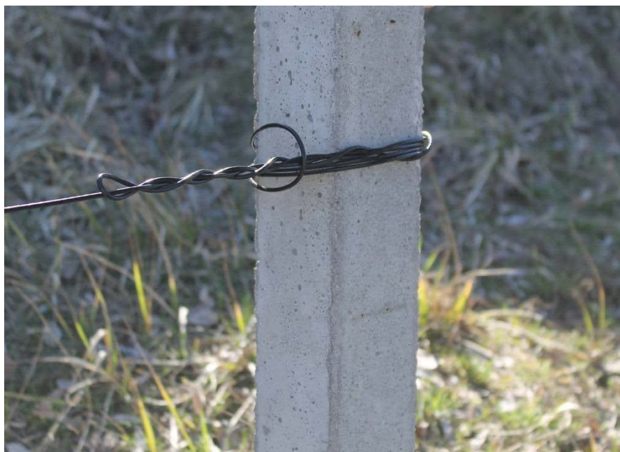
Закрепление троса на первом крайнем столбе
