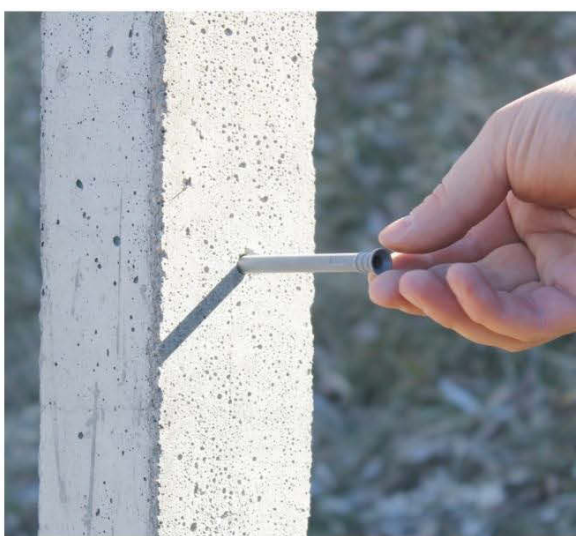
Установка пластикового дюбеля
