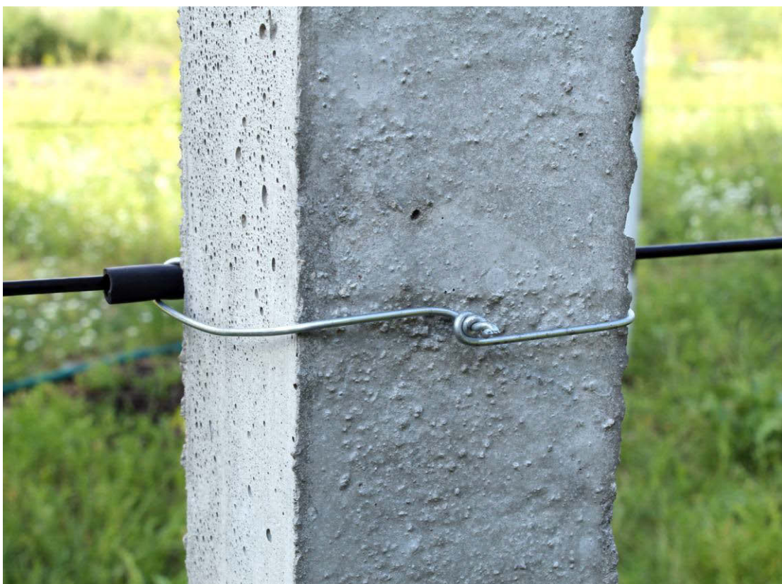
Закрепленная на столбе проволока
