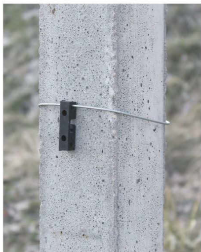
Фиксация клипсы и подтягивание проволоки
