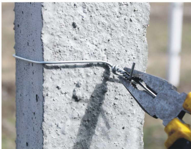
Фиксация клипсы и подтягивание проволоки
