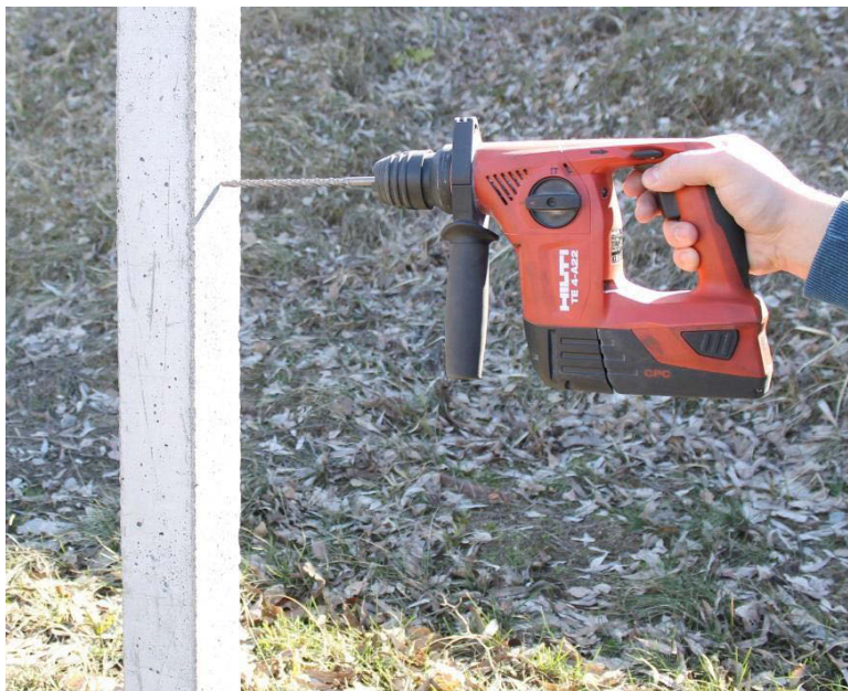
Сверление бетонных столбов
