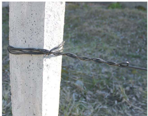
Закрепление троса на втором крайнем столбе
