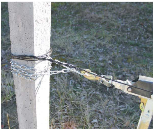
Закрепление троса на втором крайнем столбе
