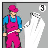
Грунт тщательно перемешайте до равномерного распределения кварцевого наполнителя и нанесите на основание валиком, кистью или щеткой тонким слоем, не допуская скопления излишков грунта на поверхности.
