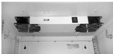
Установленный вентиляторный блок в шкаф
