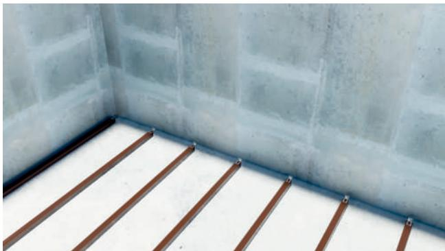
Первая доска задвигается в паз Кляймера стартового до упора.
