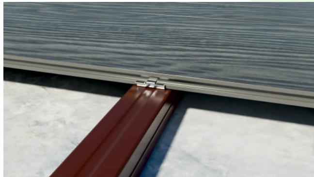
В процессе монтажа террасной доски с использованием Кляймеров Н6, Н7 или Н8 не просверливайте отверстие диаметром более  $\frac{3}{4}$  диаметра шурупа.
