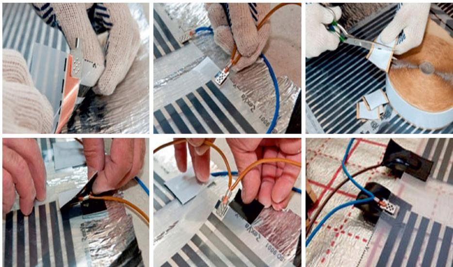
Сделать углубления в теплоизоляционной подложке для укладки контактной группы. Провода зафиксировать клейкой лентой. Уложить под термопленку температурный датчик терморегулятора.
