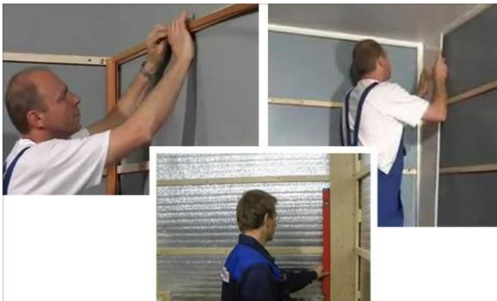
Монтаж необходимой фурнитуры и первой пластиковой панели.
