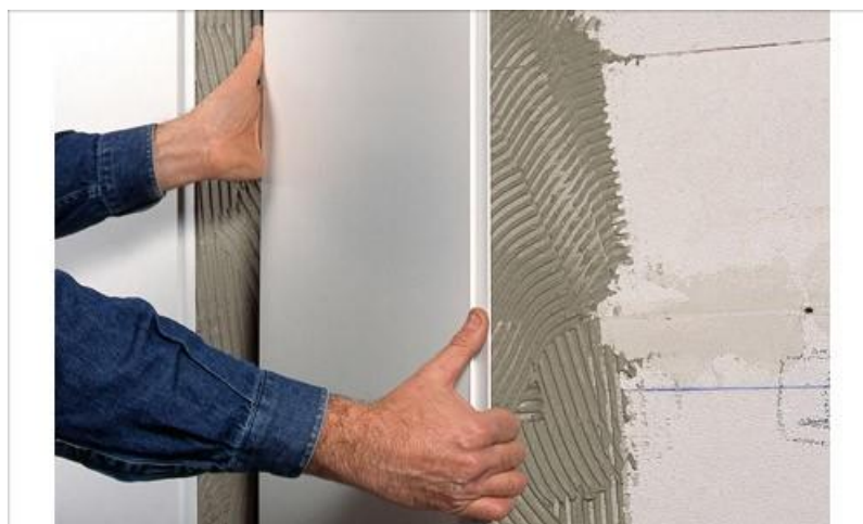
Крепление панелей на клей сразу на стены, не используя обрешетку.
