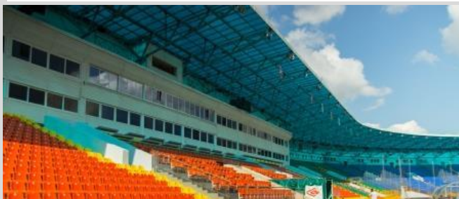
Кровля футбольного стадиона, г. Казань
