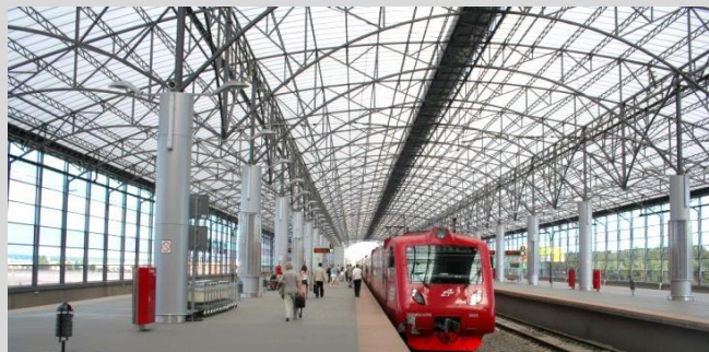
Кровля вокзала аэроэкспресса Шереметьево
