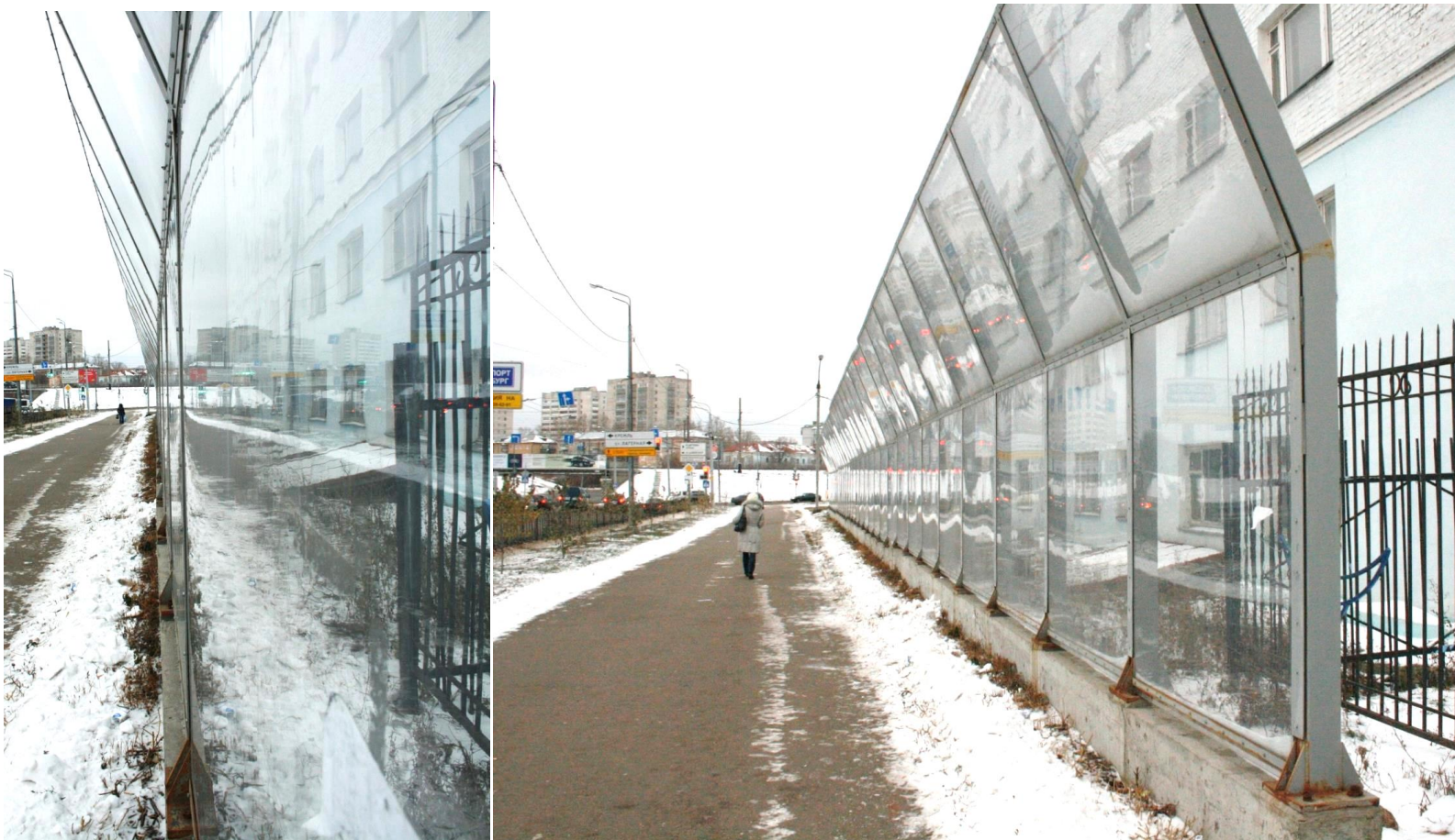
Шумозащитные экраны речного техникума г. Казань монолитный поликарбонат, прозрачный, толщина 6 мм
