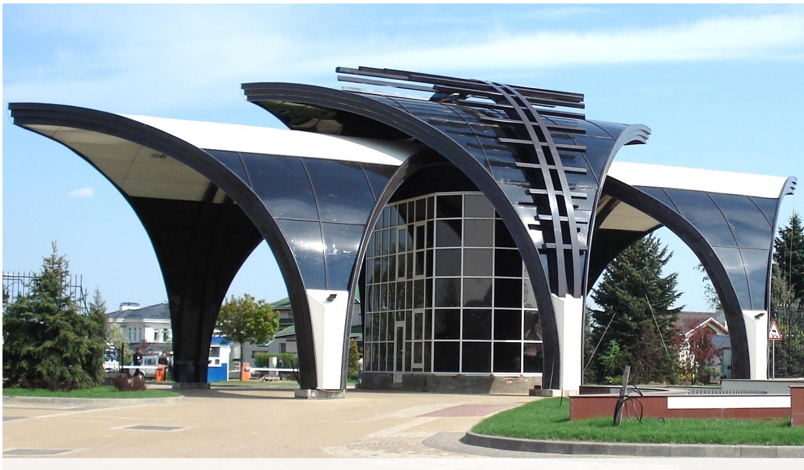
КПП коттеджного поселка в г. Тула монолитный поликарбонат, цвет бронза Т 25%, толщина 6мм
