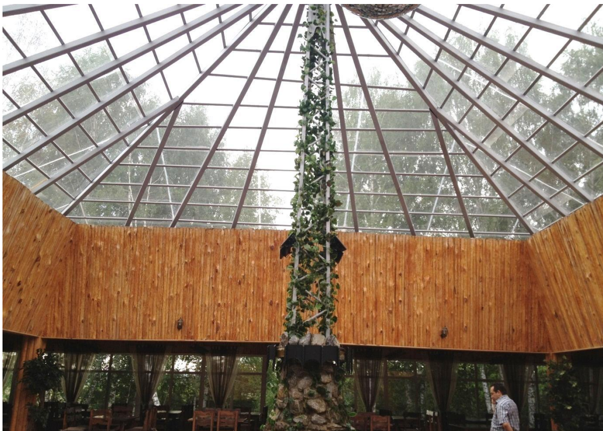
Ресторан в г. Томск монолитный поликарбонат, цвет прозрачный, толщина 5 мм
