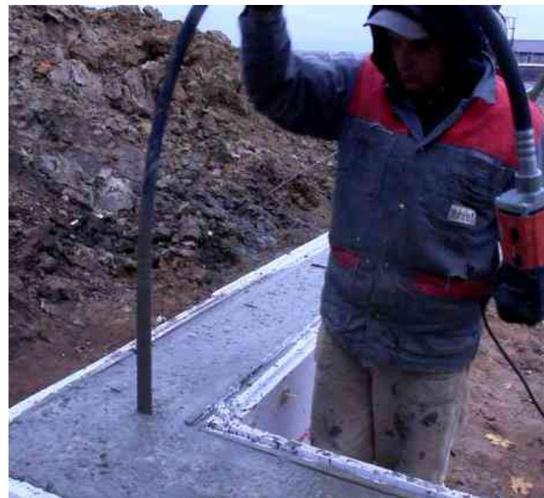
Вибрация бетона с помощью глубинного вибратора.
