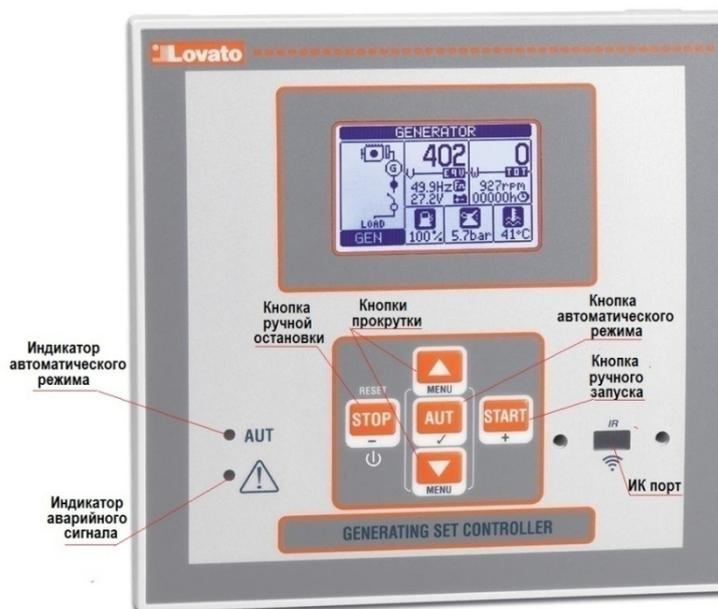
**Светодиод индикации режима AUT (зеленый)** – указывает на включенное состояние автоматического режима.
