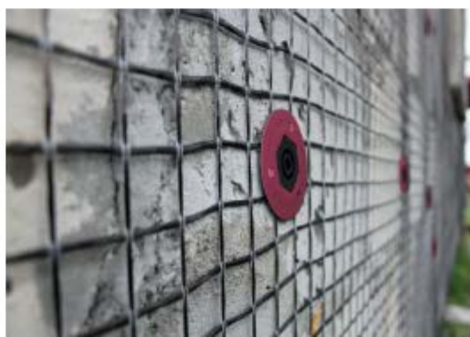
Усиление фасада армирующей сеткой для штукатурки
