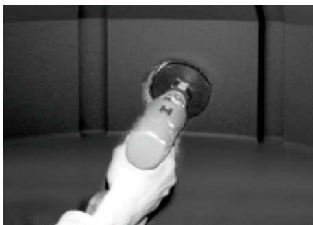
Рис. 10 Сверление отверстия для установки ЗПТ
