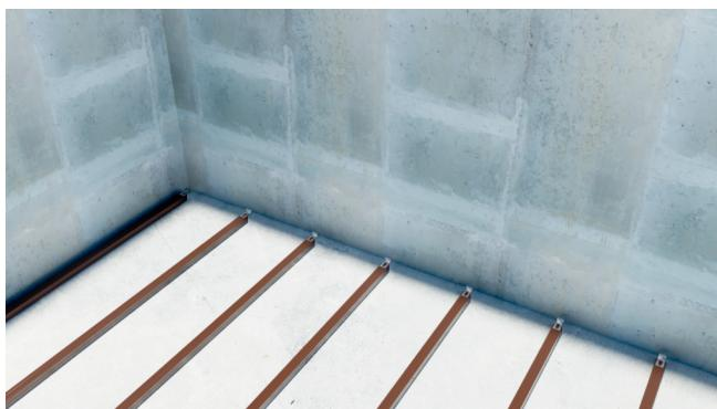
Первая доска задвигается в паз Кляймера стартового Н6.8 или Н7 до упора.
