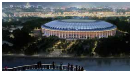
Стадион «Лужники» г. Москва. Главный распределительный щит (ГРЩ) 2000 А
