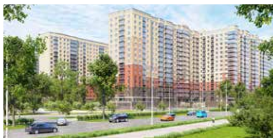
ЖК «Две столицы» г. Санкт-Петербург. Главный распределительный щит (ГРЩ) 2000 А
