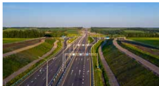
Трасса М-4 «Дон» Тульская область. 6 комплектных трансформаторных подстанции БКТП.
